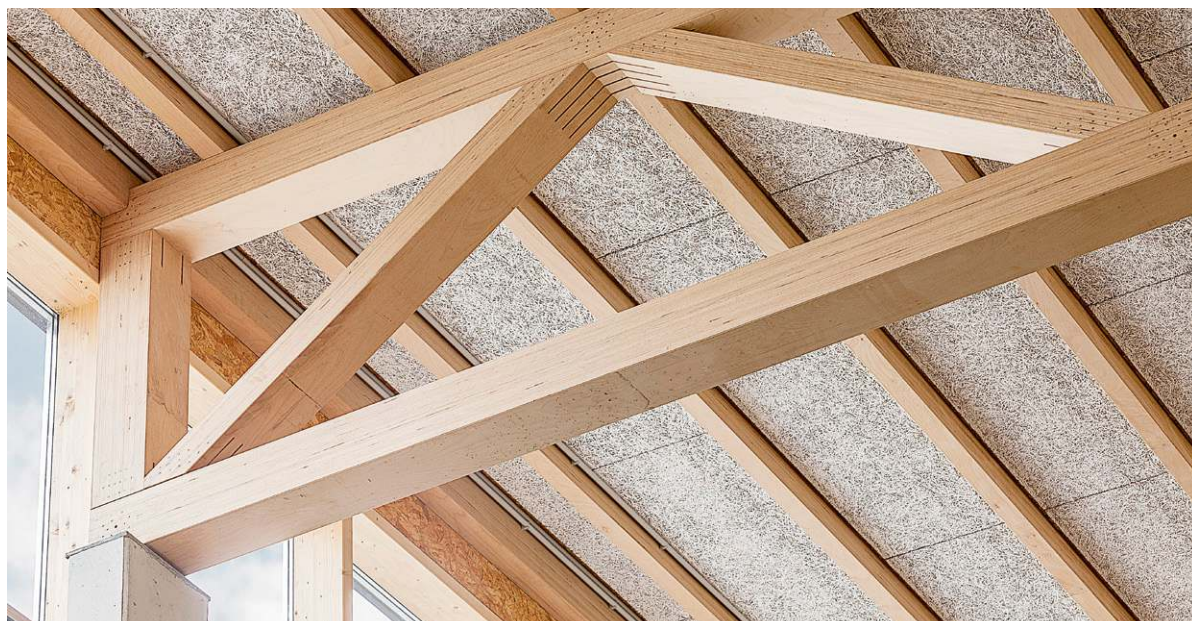
BauBuche Fachwerkträger mit BSB-Verbindung, i+R Holzbau
