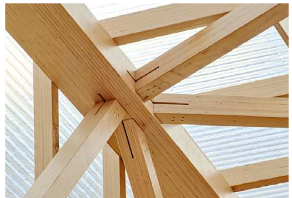
Anschlussdetail mit Stabdübel-Schlitzblechverbindung Projekt Zukunftspavillon Frankfurt Holzbau Hess Timber GmbH Fotos Rensteph Thompson, Chris Kister
