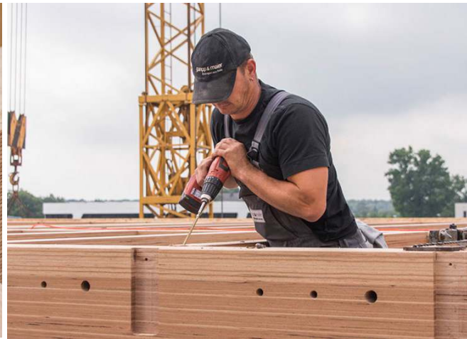
Anschluss Pfosten-Balken
